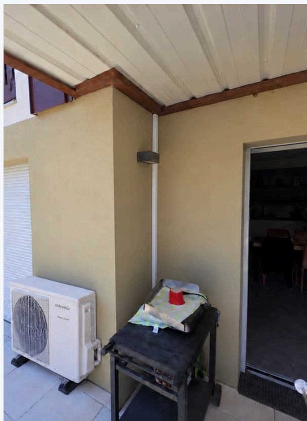
APRÈS — Rendu après travaux (photomontage) : unité extérieure au sol sur plots devant le pilier, goulotte blanche dans l'angle du mur
